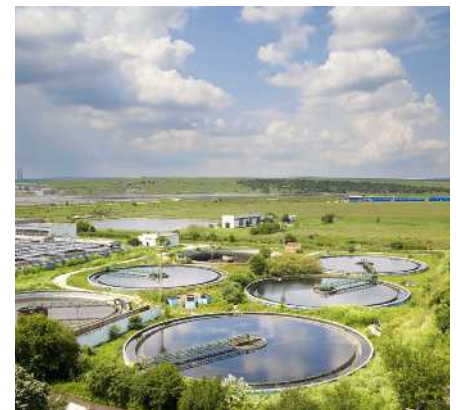
Sauberes Wasser dank hoher Anlagenverfügbarkeit
